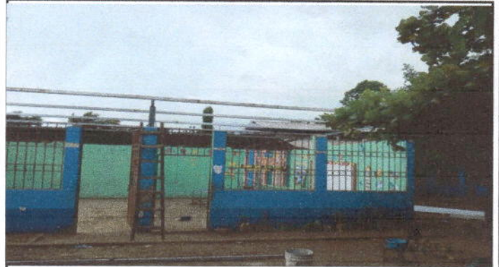
Foto 2: Sustrucción de lamina calibre 26 en aulas modulo 3.
