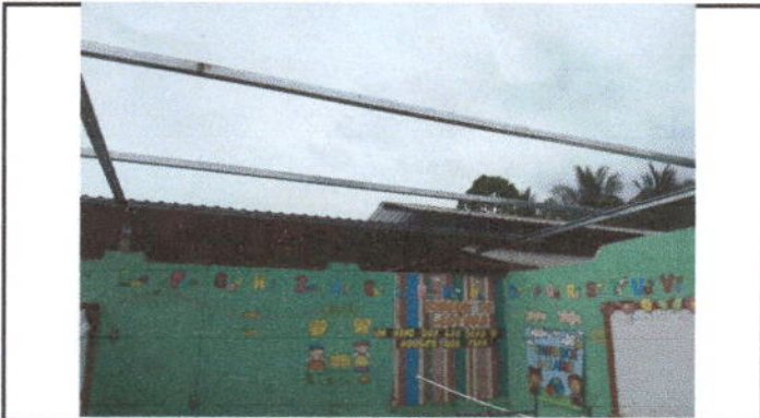
Foto 3: Sustrucción de estructura de madera por metal en aulas.
